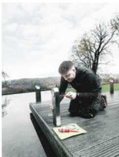
Warum sieht man eigentlich so oft Edelstahlelemente mit Rostbefall? Ein Grund: Häufig wird mit Werkzeug aus „normalem“ Stahl verschraubt, das Fremdrost erzeugen kann. Das ist ärgerlich. Wir waren überzeugt, dass man das verhindern kann. Durch Schraubwerkzeuge, die ebenfalls aus Edelstahl sind und die notwendige Industriestandard-Härte haben. Fremdrostbefall wird verhindert, eine spezielle Vakuumeshärtung sorgt für die notwendige Härte. In VDE-Ausführung.
