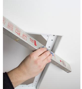
4. Geben Sie den Einbaurahmen in den Ausschnitt. Achten Sie darauf, dass der Rahmen bündig mit der Decke bzw. Wand abschließt. Überprüfen Sie mit z.B. einer Wasserwaage alle Seiten.
