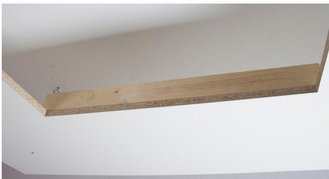
3. Bitte beachten Sie, um den Rahmen mittels Schrauben befestigen zu können, müssen an allen 4 Seiten des Ausschnitts Montagehilfen (wie z.B. ein Aluprofil oder Kanthölzer fest verbunden mit der Decke) montiert sein.
