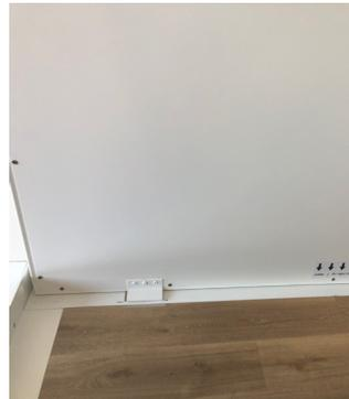
2. Lösen Sie das Paneel vom Einbaurahmen, indem Sie an der Vorderseite auf das Paneel drücken und die Federn entriegeln. Danach klappen Sie das Paneel bei den Federn hoch und lösen Sie es aus der Einhakvorrichtung.
