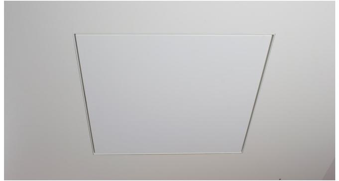
9. Falls bei der Montage zwischen dem Einbaurahmen und der Decke bzw. Wand ein Spalt entsteht, kann dieser mittels Acryl ausgebessert und übermalt werden.
