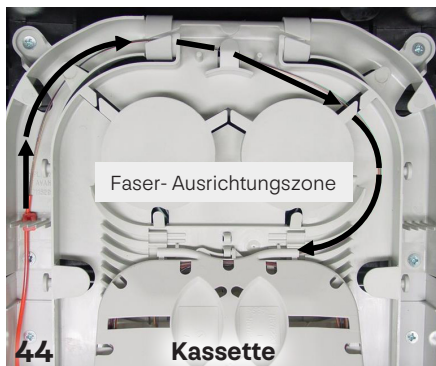
44 CMD15106 | Die Fasern kommen von der LINKEN Seite in die Faser-Ausrichtungszone und werden RECHTS in die Kassette eingeführt.
