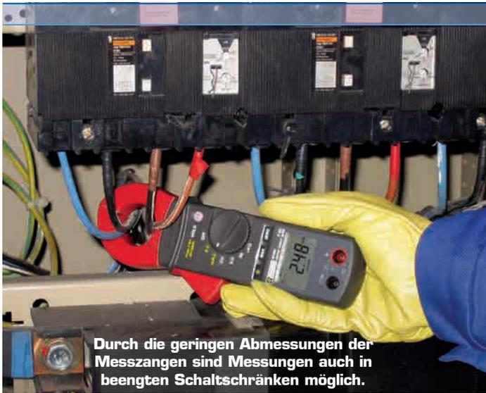
Durch die geringen Abmessungen der Messzangen sind Messungen auch in beengten Schaltschränken möglich.
