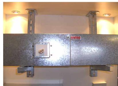
**\*) Bei Brandschutzkanälen I 30 – I 90 kann auf die Gewindestange (2. Abhängung) verzichtet werden, wenn in der Wanddurchführung eine Sollbruchstelle angeordnet wird (Anlage 12 abP).**
