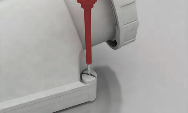
5. Befestigen Sie das Gehäuseunterteil mit dem für die Anwendung geeigneten Befestigungsmaterial an der Wand.
